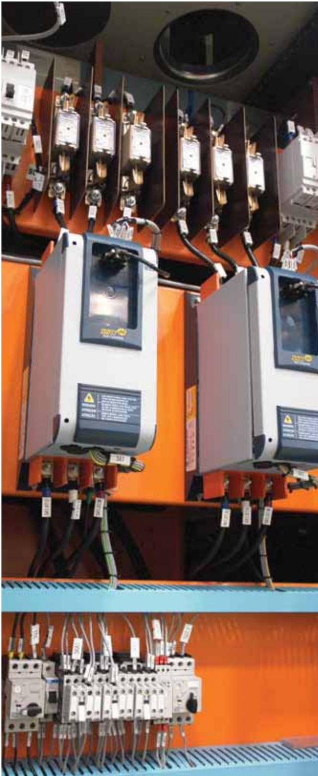
Los Arrancadores Suaves WEG optimizan las secuencias de arranque y de parada (aceleran y desaceleran), aumentan la productividad, permiten ahorro de energía / mantenimiento y protegen los motores de inducción trifásicos.
